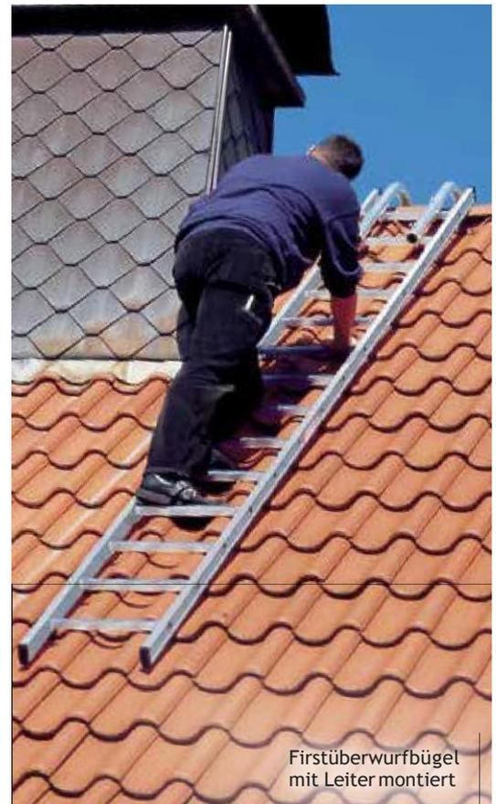
Firstüberwurfbügel mit Leiter montiert
